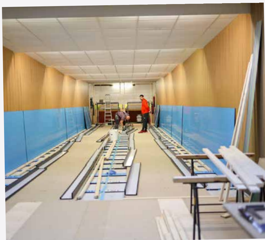
Baufortschritt bei der Errichtung der neuen Kegelbahnen
